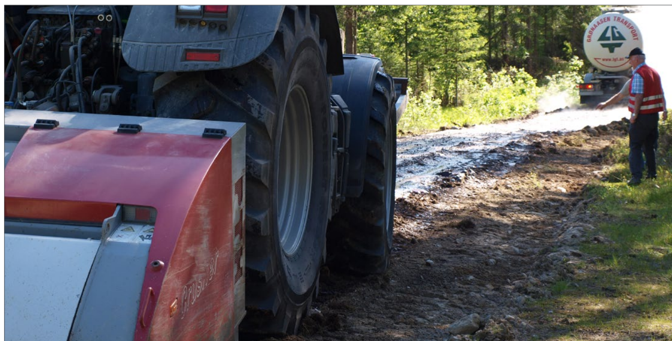
Figur V7.4. Påføring og blanding av Dustex (Foto: Jan Bjerketvedt, NIBIO).
